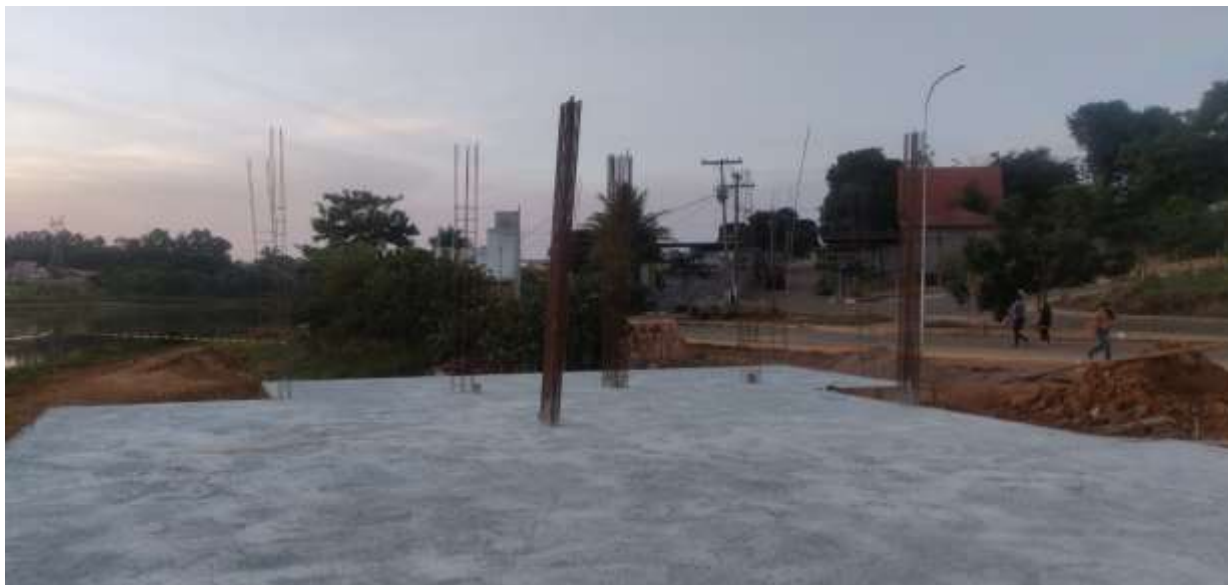
Foto 02: Laje de piso do Quiosque, onde receberá a cobertura Metálica
