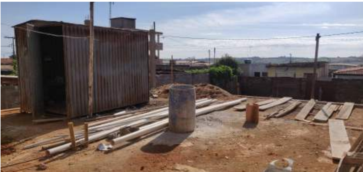
Foto 02: Tipo de obra: Varanda Cras – local da cobertura metálica
