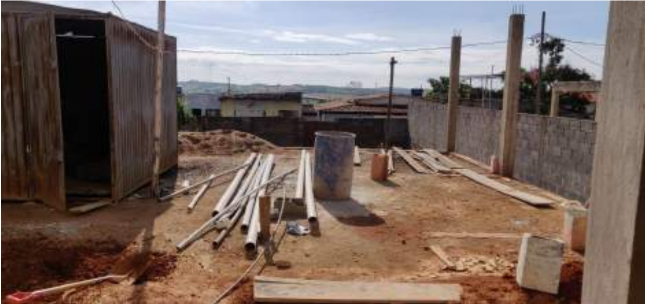
Foto 01: Tipo de obra: Varanda Cras – local da cobertura metálica
