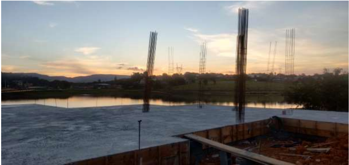
Foto 04: Laje de piso do Quiosque, onde receberá a cobertura Metálica
