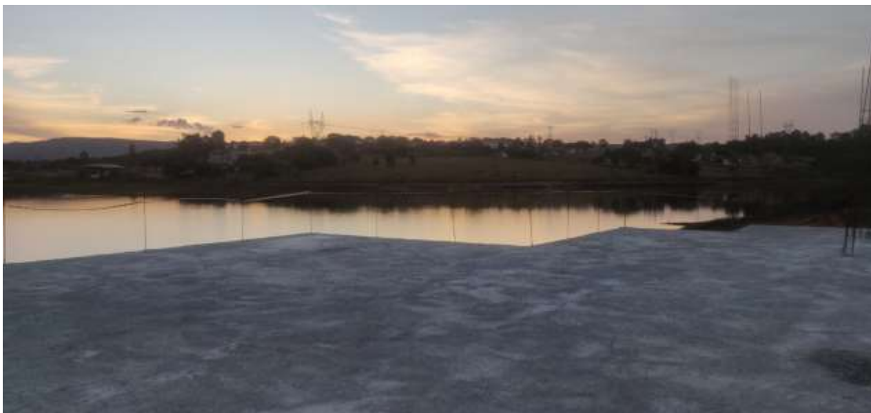
Foto 01: Laje de piso do Quiosque, onde receberá a cobertura Metálica
