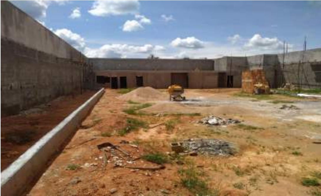
Foto 01: Tipo de obra: Quadra poliesportiva – local da cobertura metálica
