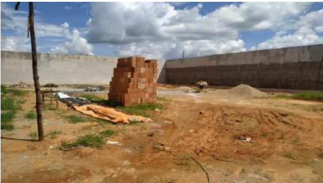
Foto 02: Tipo de obra: Quadra poliesportiva - local da cobertura metálica
