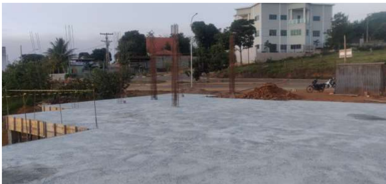
Foto 03: Laje de piso do Quiosque, onde receberá a cobertura Metálica
